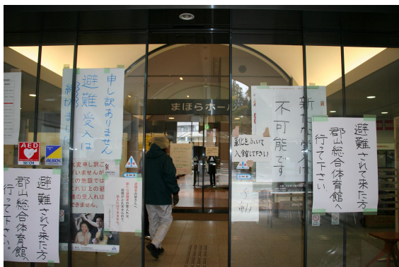
(東日本大震災時避難所となったまほらの様子)
