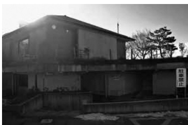
町営グラウンドのトイレ
