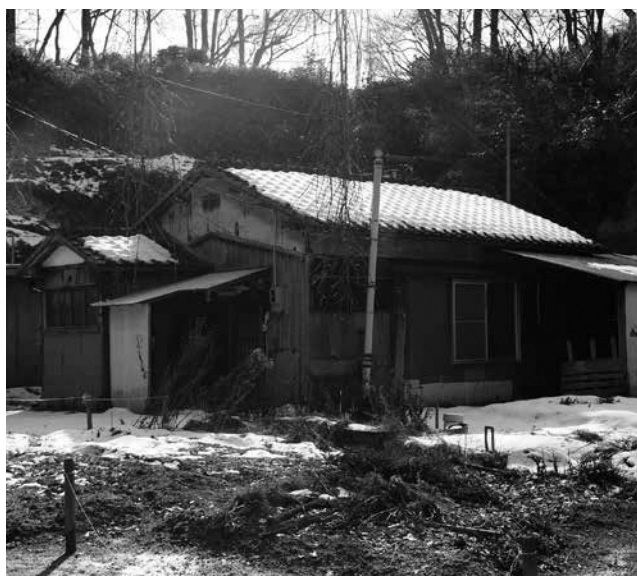
用途廃止される北町団地内の町営住宅
