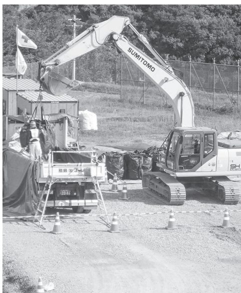
仮置き場での除染廃棄物搬出作業のようす
