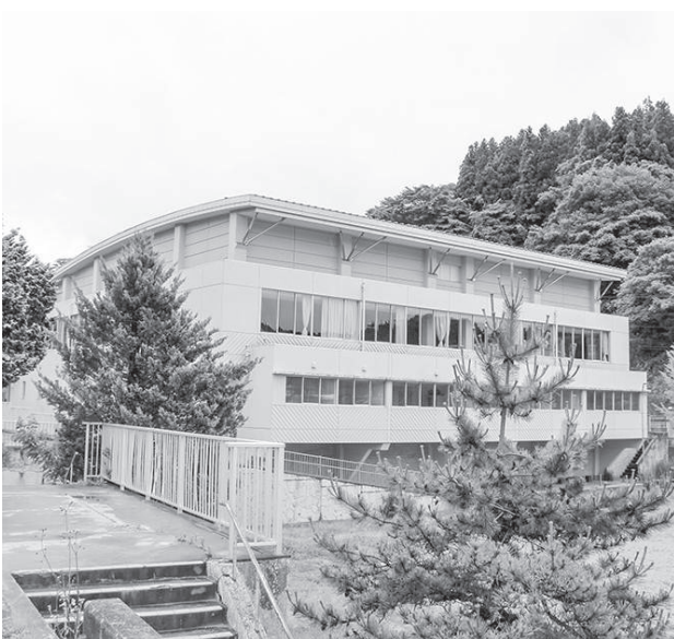
三春町民第2体育館となる旧三春中学校体育館
