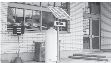
三春小学校に設置されているモニタリングポスト
