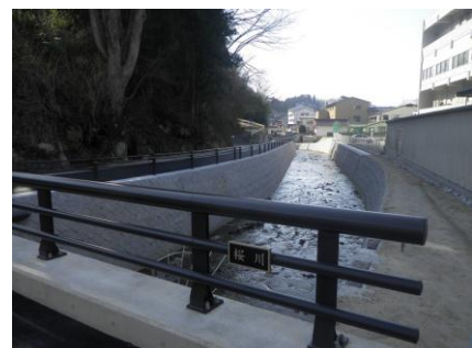
【河川改修工事が進む桜川】
