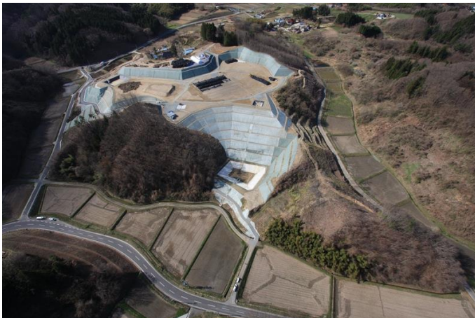
【北部三地区仮置場】
