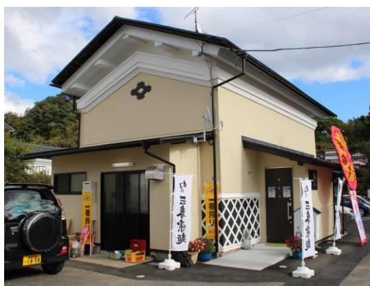
（空き店舗改修事業）
