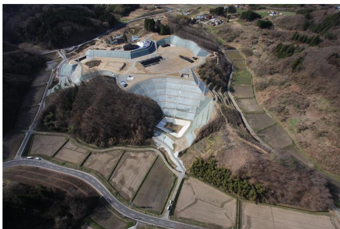
【北部三地区仮置場】
